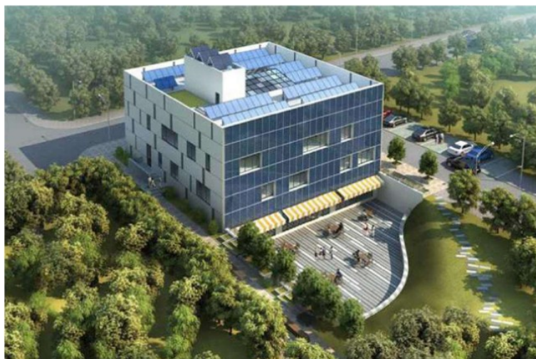
Рисунок 2. Здание Китайско–германского центра по энергосбережению, построенного в соответствии с концепцией пассивных домов
