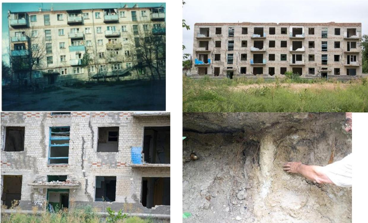
Рисунок 2. г. Георгиевск, разрушение 5-этажных домов ЖСК «Чайка» после закачки цементных растворов
