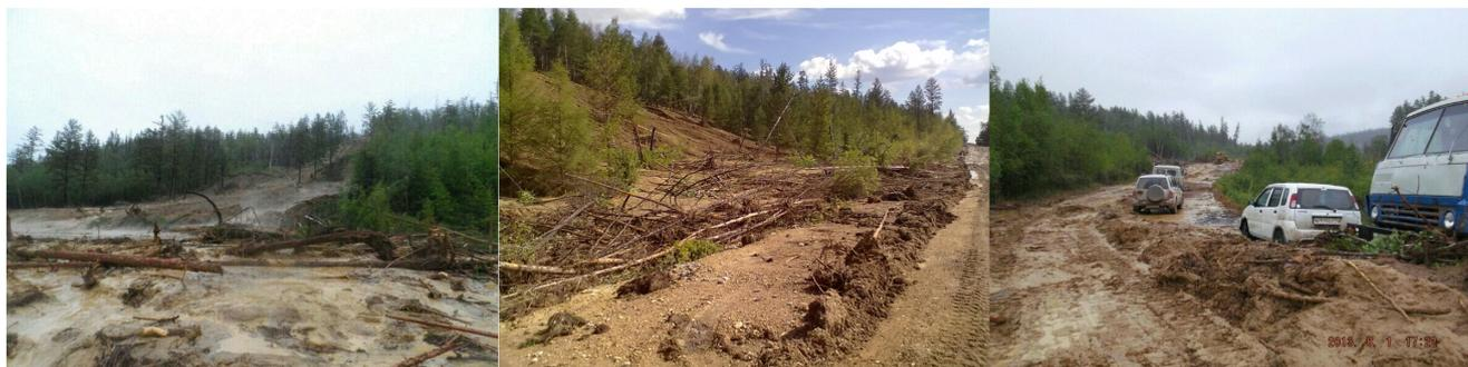
*Рисунок 1. Различные чрезвычайные явления: сильный оползень на автодороге «Амга» - слева и в центре, автодорога «Амга» после оползня временно закрыта с 16 августа – 19 августа 2013 г. - справа*
