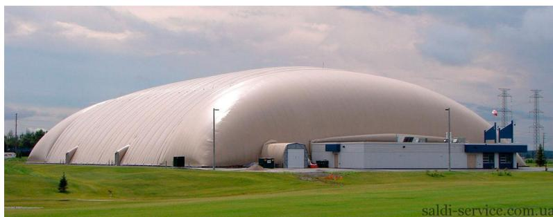
*Рисунок 1. Воздухоопорное пневматическое сооружение*
