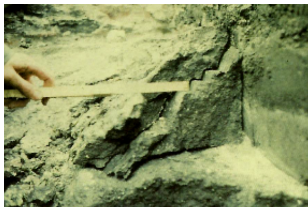
Рисунок 3. Расслоение периферийного шва в месте скоса [3]
