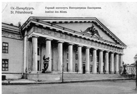
Рисунок 8. Центральная часть главного фасада. Горный институт в Ленинграде, 1806-1811 гг. Архитектор А. Н. Воронихин
