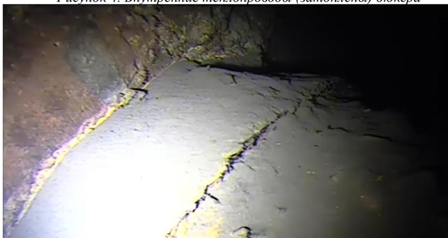
*Рисунок 5. Иловые отложения на внутренних теплопроводах дюкера*
