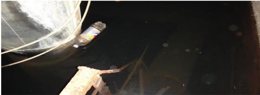
*Рисунок 2. Затопление береговой камеры и дюкера. Контакт трубопровода с водой*
