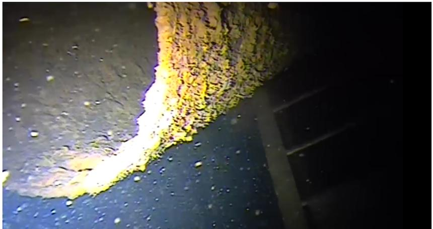
*Рисунок 3. Внутренние теплопроводы (затоплены) дюкера*
