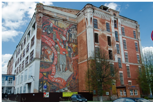
Рисунок 2. Суперграфика на фасаде Шелкового комбината в г. Наро-Фоминск
