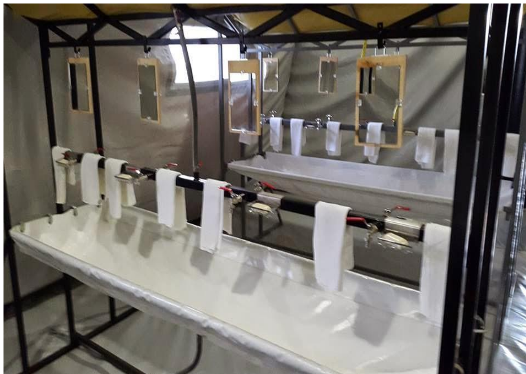
Рисунок 1. Умывальник с функцией кипячения воды для наполнения индивидуальных фляг
