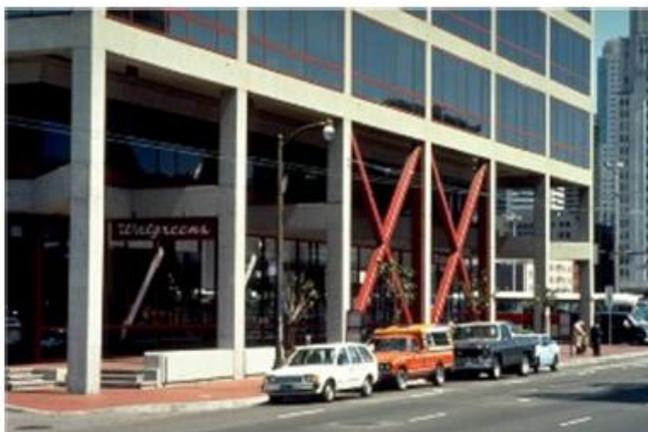
Рисунок 2 – Усиление здания диагональными связями
