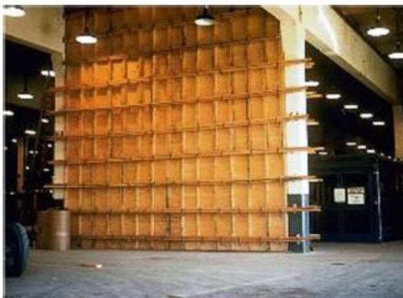
Рисунок 3 – Устройство диафрагмы жесткости в цехе
