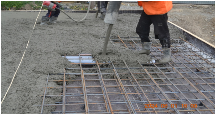
Рис. 1 Установка пустотообразователей в монолитной плите перекрытия.
